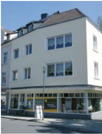
Umbau eines Wohn-/Geschäftshauses
